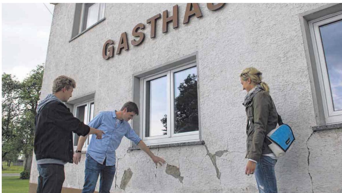
Die Konstanzer Studierenden untersuchten unter anderem die Bausubstanz von Gebäuden in Buchheim, so beim Gasthaus „Hirsch“.
